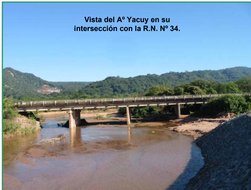
Vista del A° Yacuy aguas arriba
